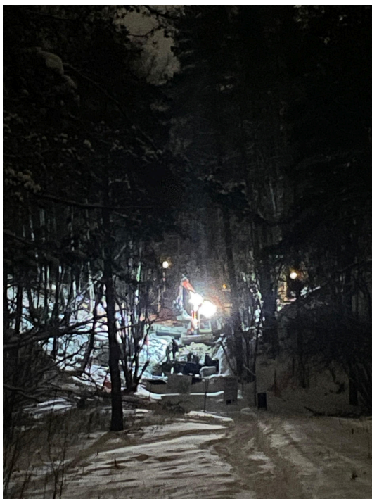
Pilt 3. Treppide remontimine.
